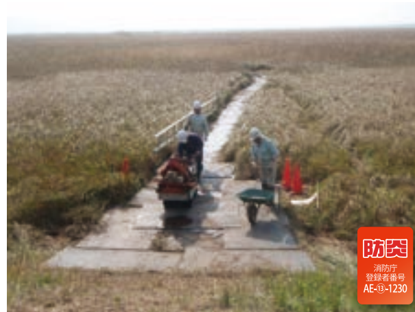
軽作業路 使用製品:PSK (湿原地養生)
