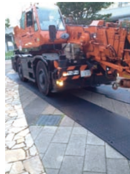
高所作業車両搬入路 (インターロッキング養生)
