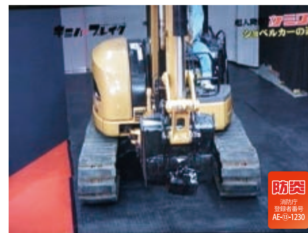
作業車搬入路 使用製品:PSK (コンクリート床養生)
