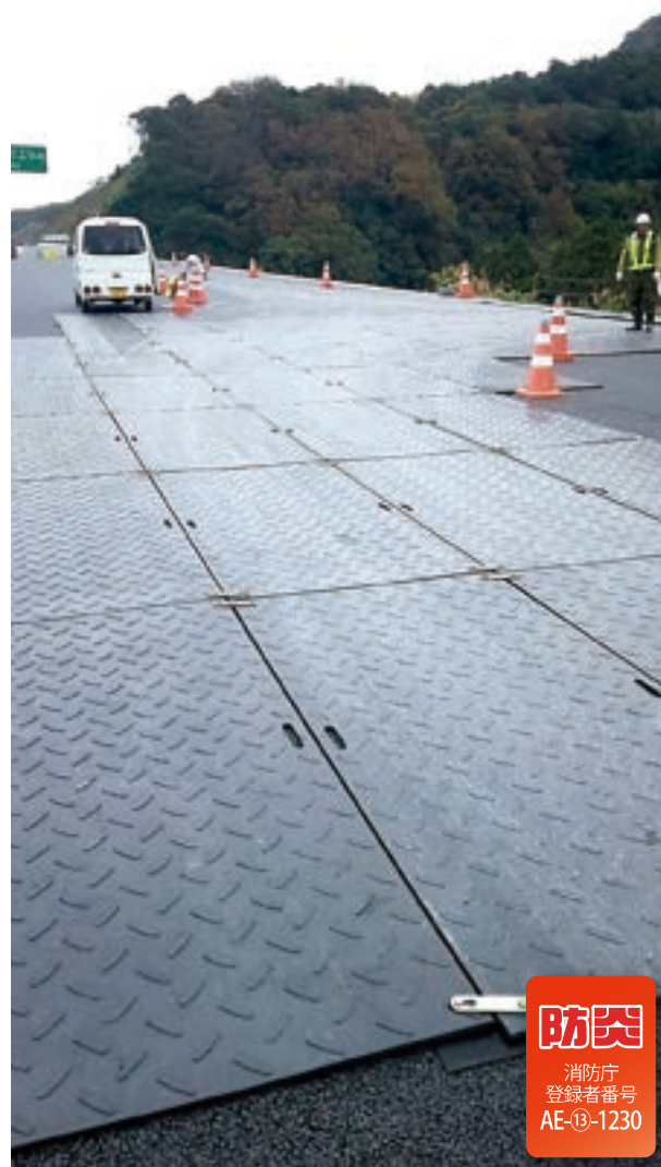
高速道路 使用製品:PSK+ジョイントマット (完成舗装面保護)
