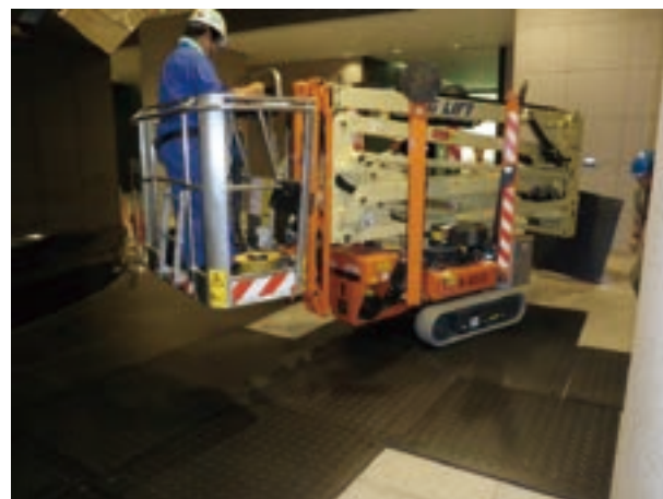
作業車搬入路 使用製品:PSL (ビル内床養生)
