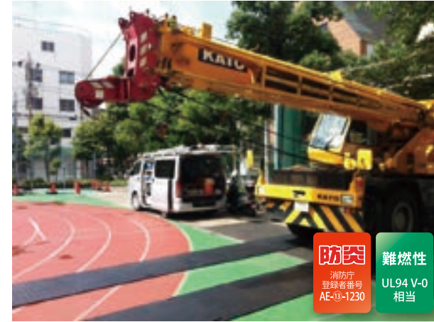
小学校耐震工事 使用製品:PSK,PSY 校庭養生
