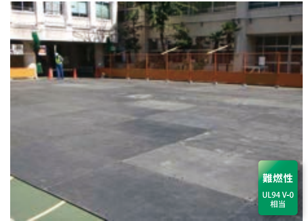
小学校耐震工事 使用製品:PSY 校庭養生
