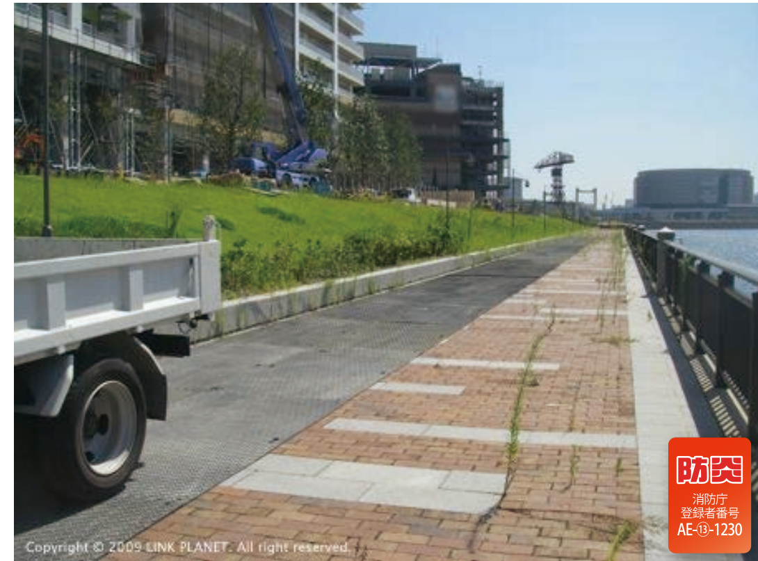
河川遊歩道車両搬入 使用製品:PSK (インターロッキング養生)
