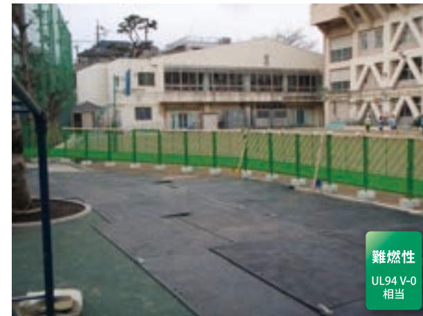
資材搬入路 使用製品:PSY (学校校庭タータン部養生)
