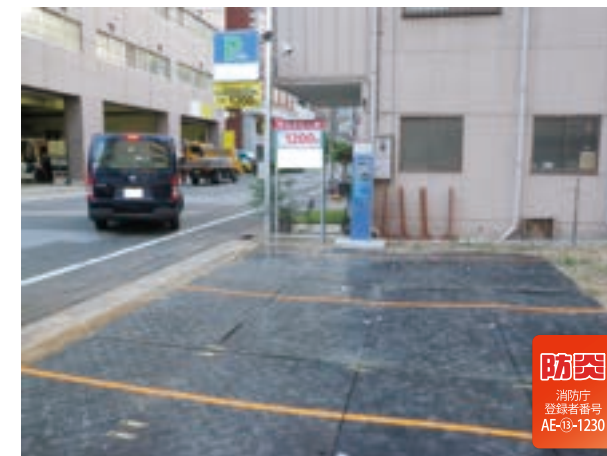
簡易駐車場 使用製品:PSK、アンカー (土面養生)
