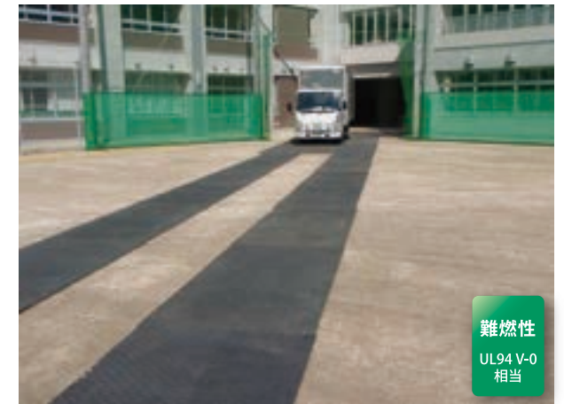
工事車両搬入路 使用製品:PSY (学校校庭養生)
